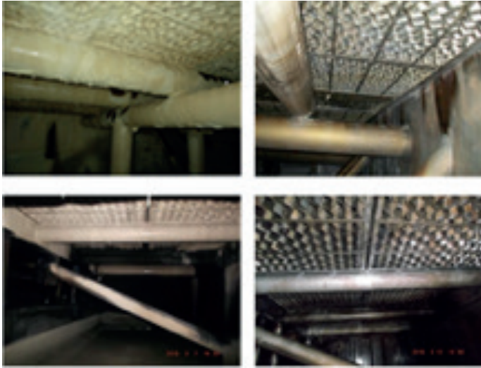
Imagen 1 - Relleno del condensador antes y después de la limpieza química
